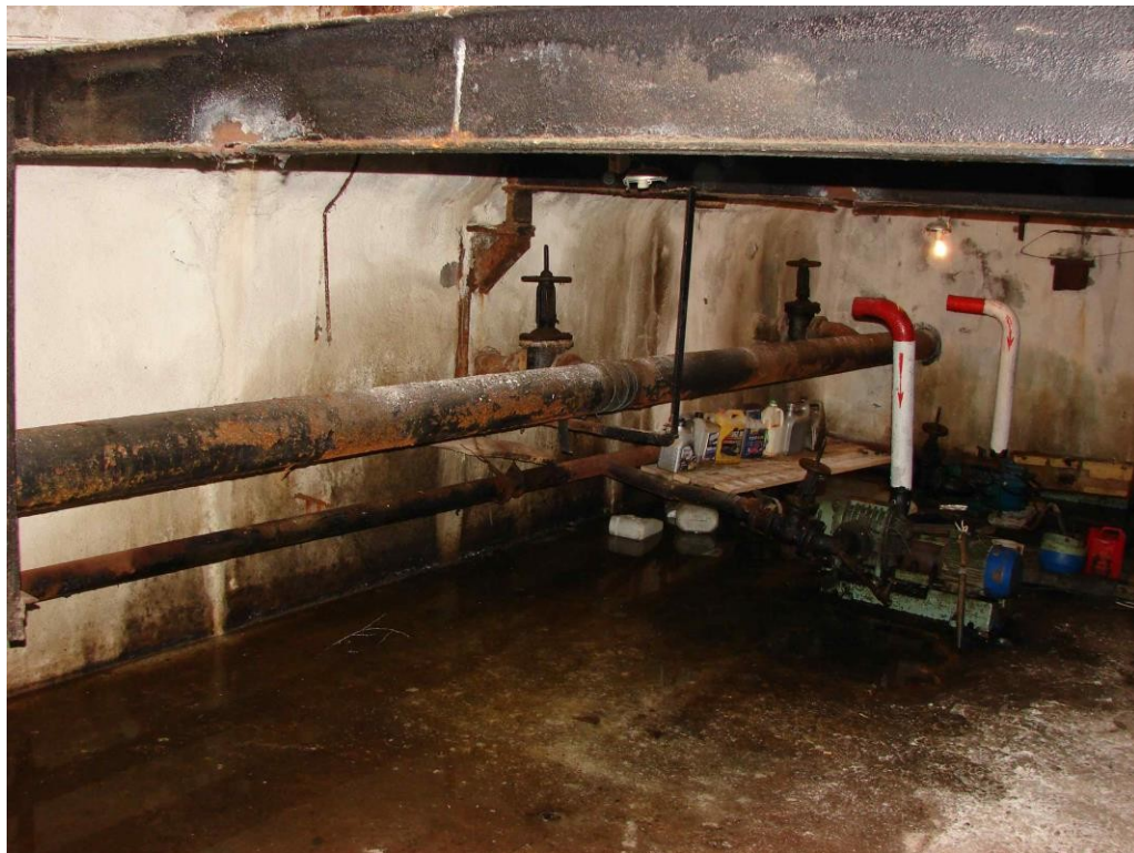
Рисунок 10. Оборудование КОС в д. Иссад
