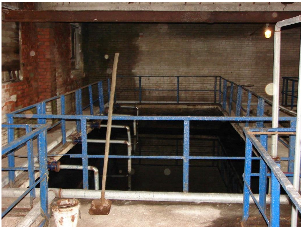
Рисунок 11. Аэротенки - отстойники.
