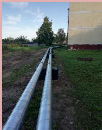
Проведена замена участков теплосети от д. № 1 до д. № 14. и от д. № 1 до д. № 13 в дер. Иссад, мкр. Центральный
