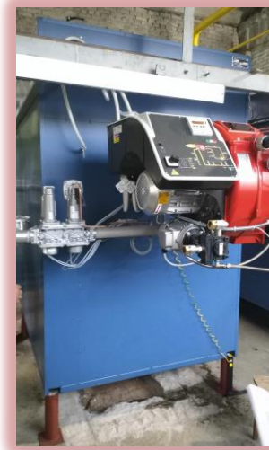
Проведена замена котлоагрегата КВГМ-2,5-95 в котельной дер. Иссад, ул. Лесная, д.3
