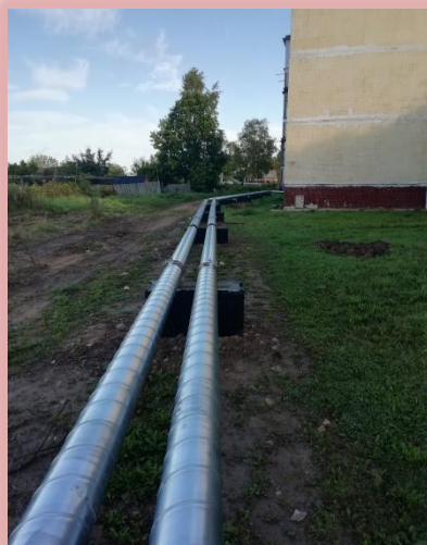
Проведена замена участков теплосети от д. № 1 до д. № 14. и от д. № 1 до д. № 13 в дер. Иссад, мкр. Центральный
